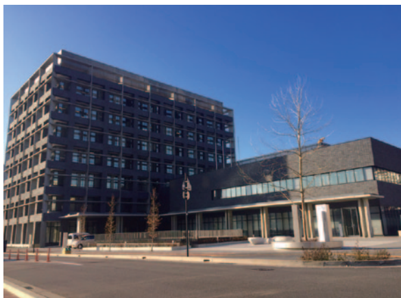
広島県立広島がん高精度放射線治療センター。左の建物は広島県医師会と地域医療総合支援センター
